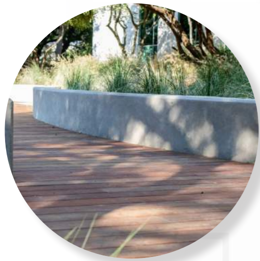
Betonnen zitrand met houten dek
